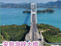
来島海峡大橋
